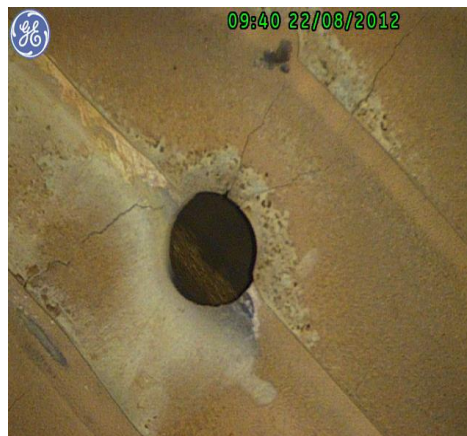
(图 b) 燃烧室机匣表面涂层脱落
