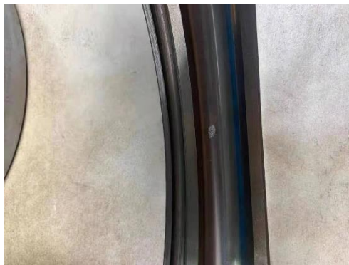
(b) 故障剥落形貌
