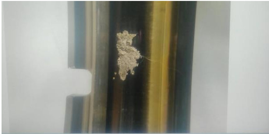
某支点外圈剥落主轴承
